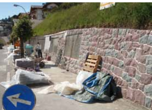
S. Cristina, i lavori procedono a pieno ritmo
